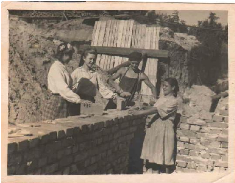
На будівництві гуртожитку № 2
